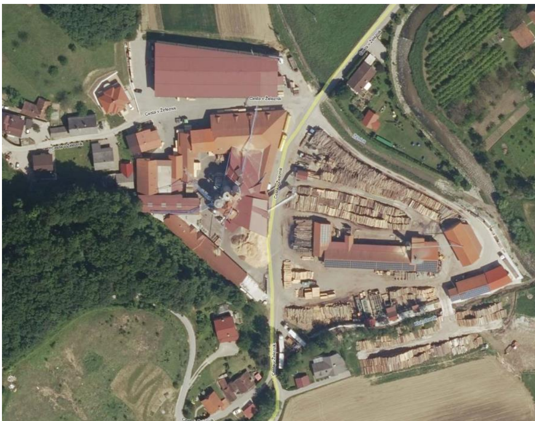
Slika 5: Lokacija kotlovnice Toplotne oskrbe Loče
